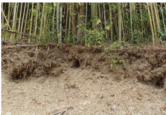
圖2 即使邊坡塌陷，桂竹根系仍緊抓表土(汪大雄 攝)
