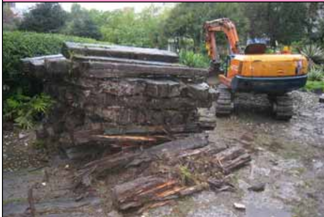
多肉植物區內正在整建，原有的杉木已被移除
