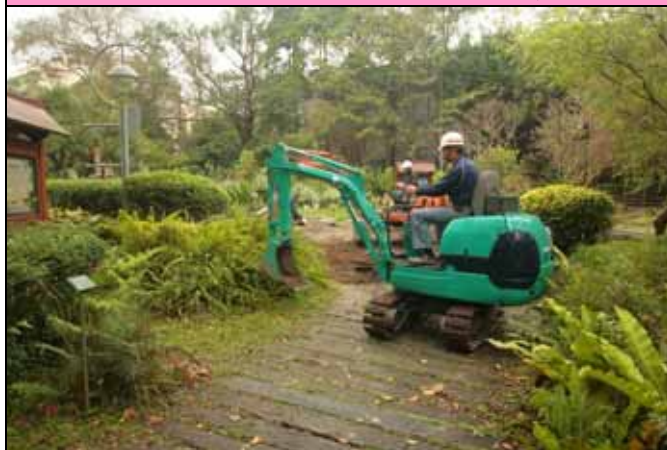
園區步道整修工程正如火如荼的進行中
